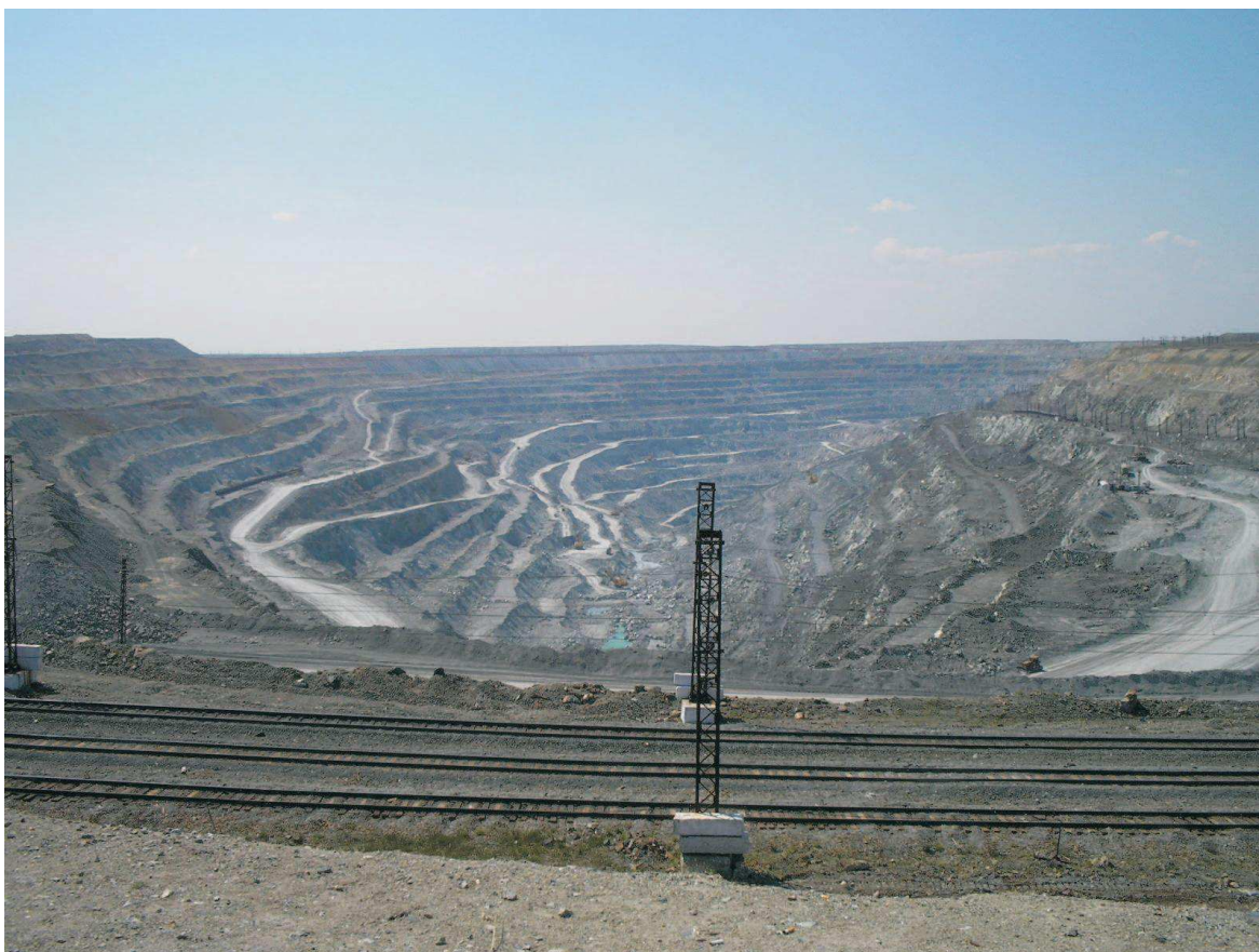
Рис. 3. Карьер отработки Джетыгаринского месторождения хризотил-асбеста
