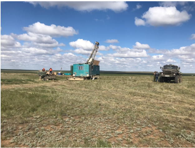
Рисунок – 3 Панорама участка геологоразведочных работ Кутюхинского месторождения
