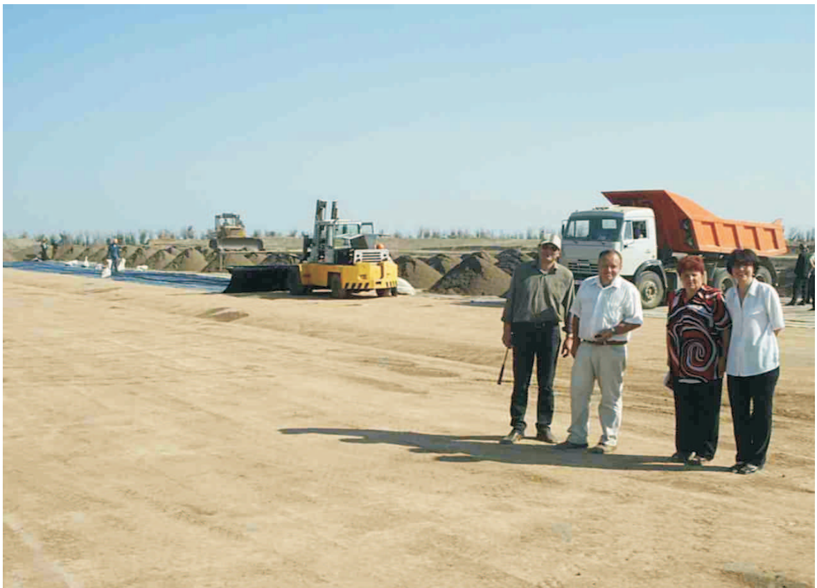
Рис. 7. Формирование основания штабеля на участке кучного выщелачивания рудника Комаровский На фото (слева направо): Ф. Н. Джафаров, Ю. Н. Гилев, А. В. Пискорская, Т. М. Каскевич
