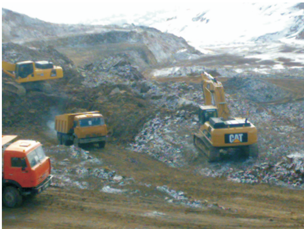
Рис. 2. Горные работы на карьере
