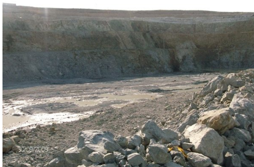
Рис.2. Южный борт карьера. Вид на уступы в корях выветривания с горизонта +135 м. Хорошо видны нисходящие очаги фильтрации с горизонта + 175 м. На переднем плане стекание рудничных вод по рабочей полке.
